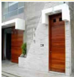
Fachada fachaleta piedra blanca
